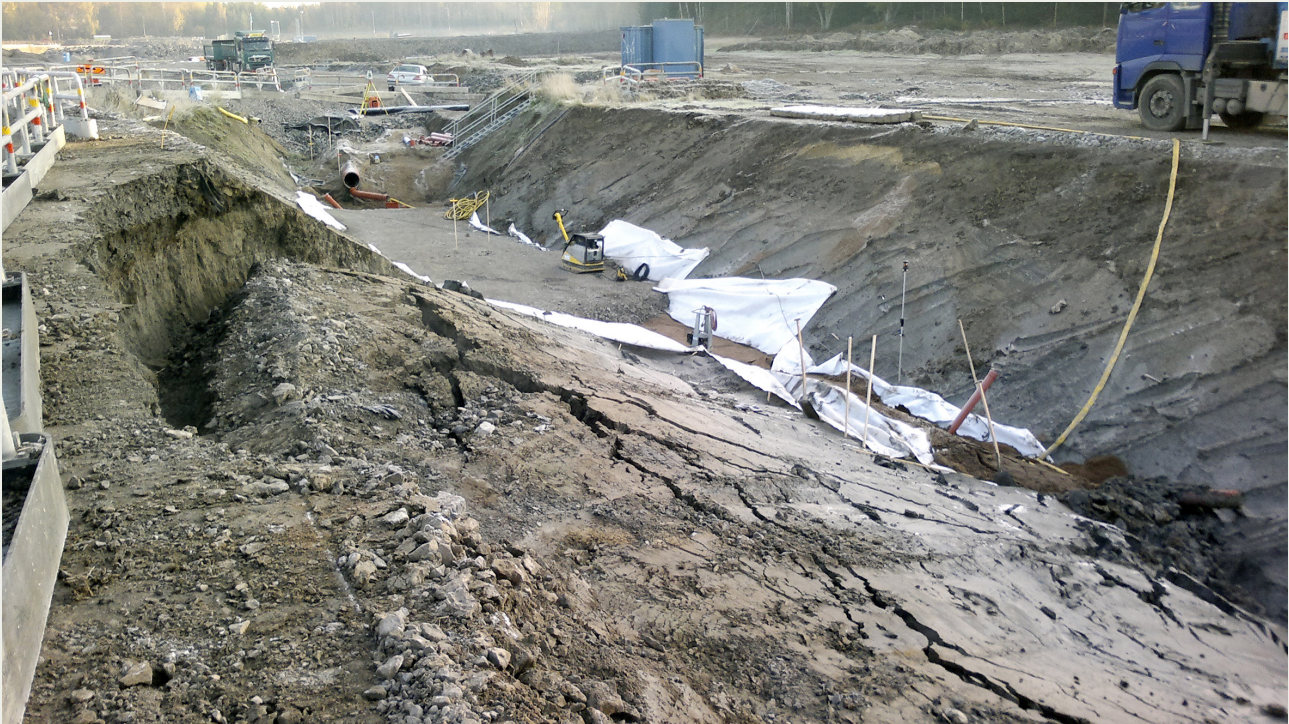
Denna schakt rasade på grund av att man utförde en alltför lång schaketapp i förhållande till jordarnas tekniska egenskaper och anvisningarna i framtagna handlingar.
